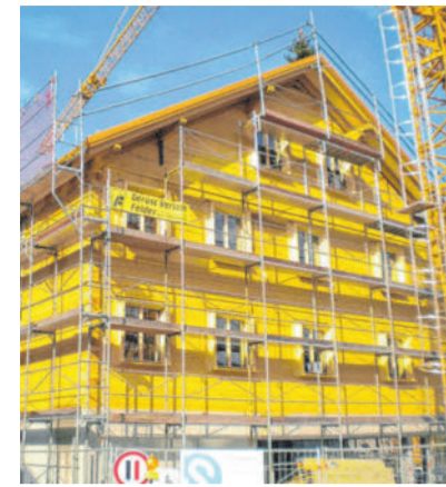
Auf der neuen Wohnanlage in Schwarzenberg wurde der Firstbaum aufgezogen.
